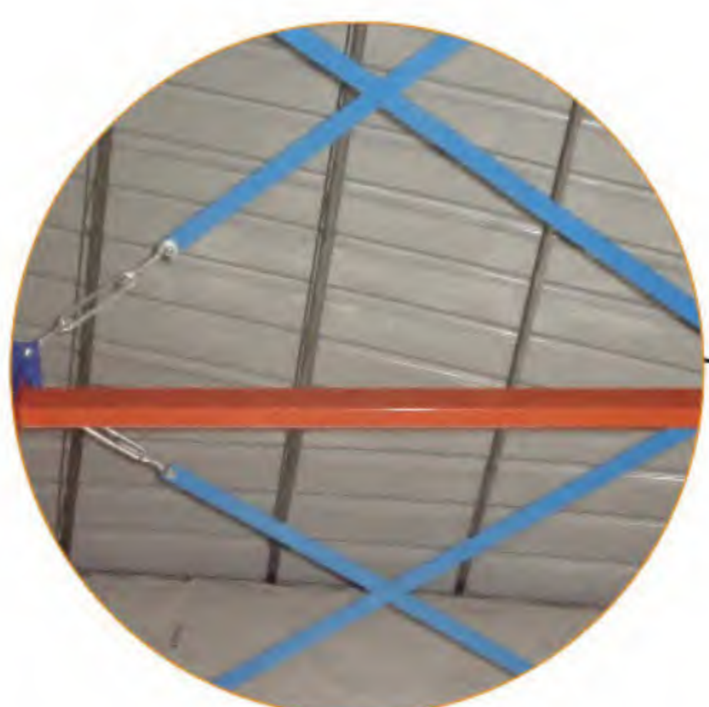
Viga de coronación
