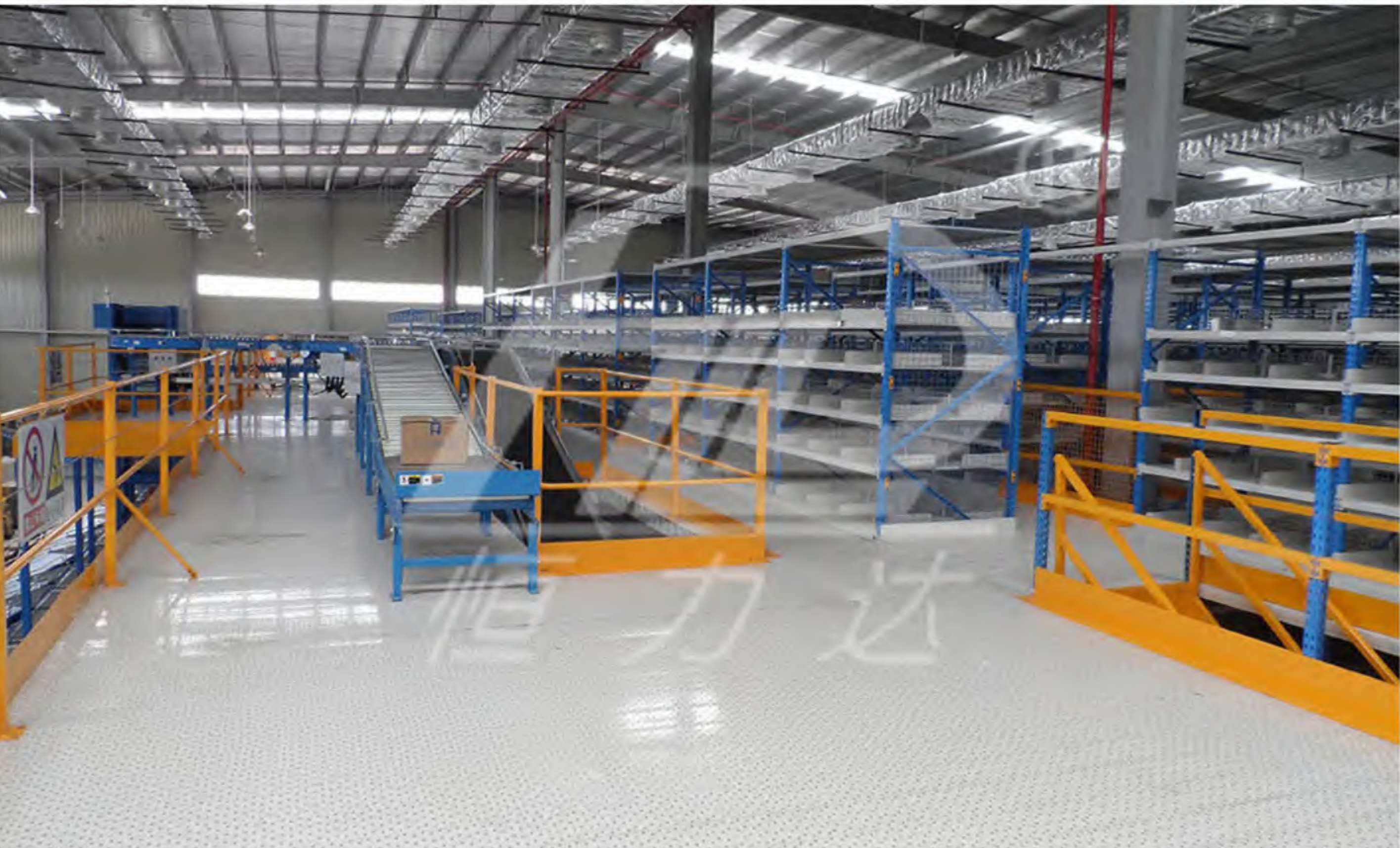
Estructura modular tipo estantería o estructura ligera de acero, que ofrece gran capacidad de carga, bajo coste y facilidad de montaje. Según las condiciones del lugar y los requisitos de uso, en general se opta por la estructura modular de estantería para cargas normales; cuando se requieren grandes luces o cargas elevadas, puede emplearse la estructura ligera de acero.
