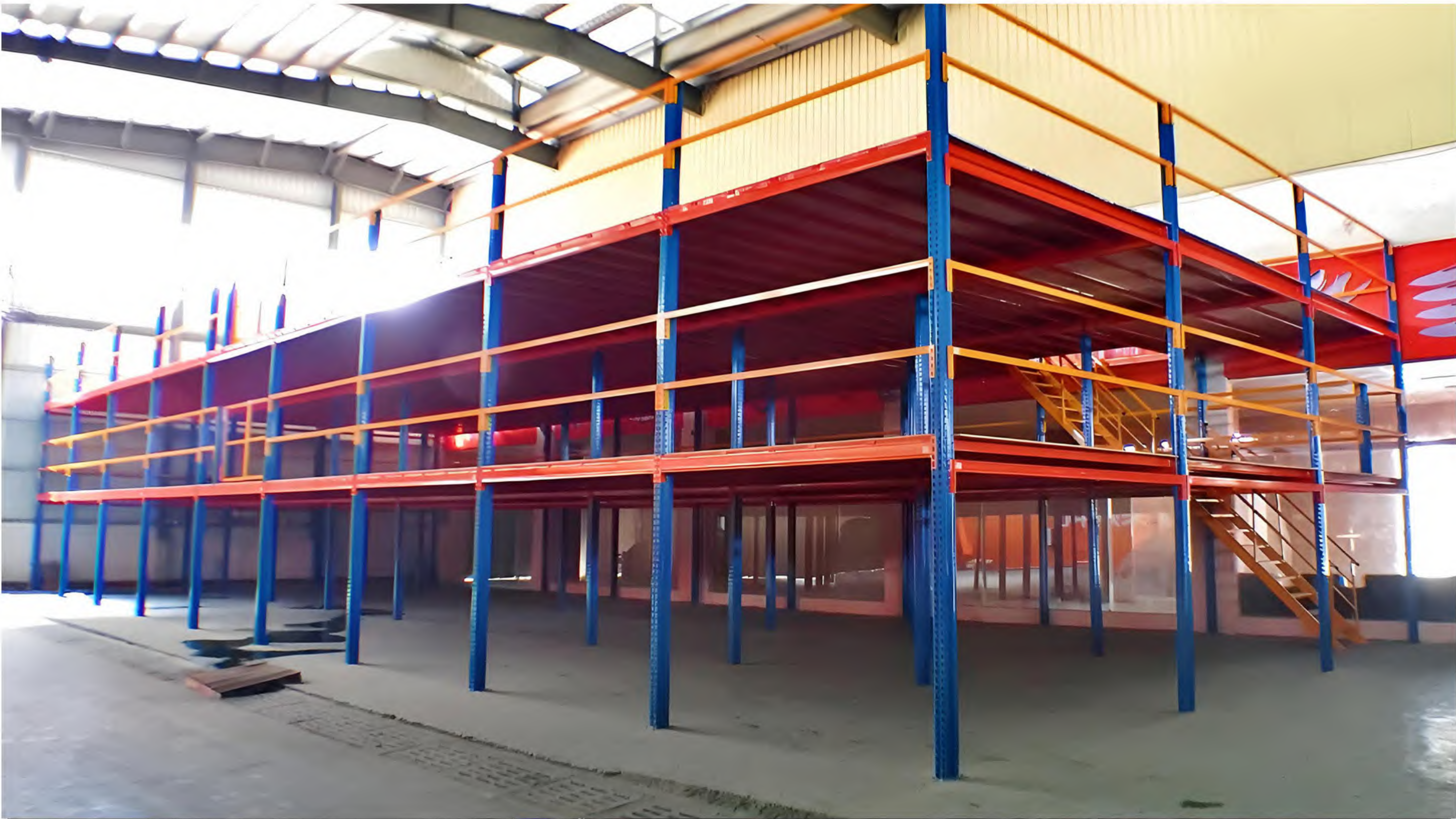
Estructura modular tipo estantería o estructura ligera de acero, que ofrece gran capacidad de carga, bajo coste y facilidad de montaje. Según las condiciones del lugar y los requisitos de uso, en general se opta por la estructura modular de estantería para cargas normales; cuando se requieren grandes luces o cargas elevadas, puede emplearse la estructura ligera de acero.
